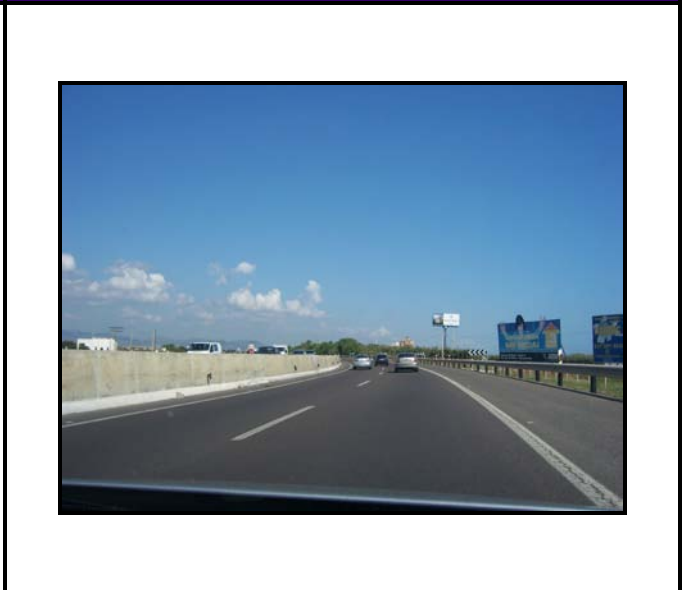
Foto 1: Vista actual de la V-21
