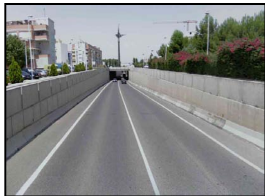
Foto 3: Vista actual de la zona de actuación
